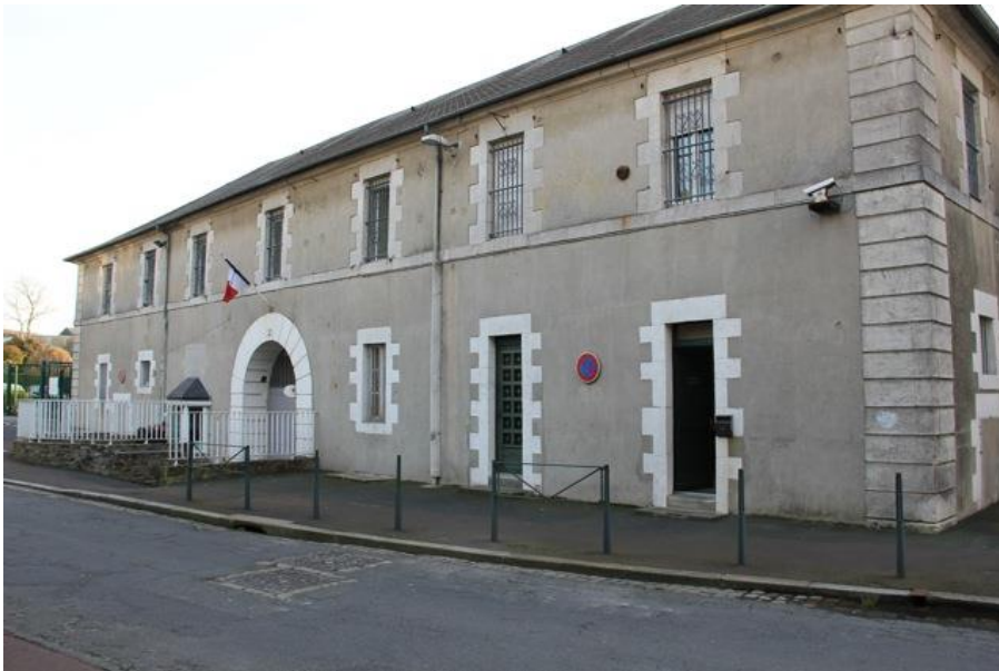
Façade nord de la maison d'arrêt
