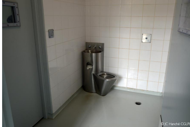
Figure 10 : Toilettes, chambre d'isolement pôle 94G15
