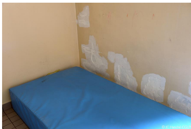
Figure 39 : pôle 94G17, chambre médicalisée unité 17A
