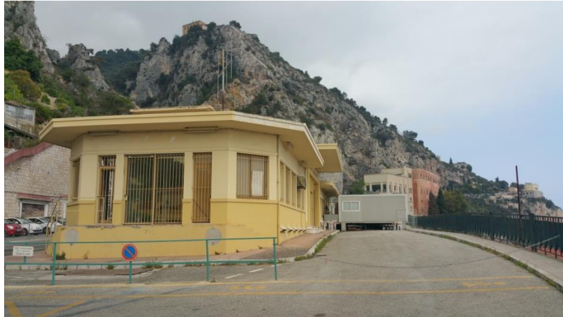
La voie montante de la RN7 et l'extension modulaire servant de bureaux
