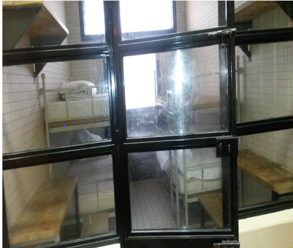
Photo 1: chambre du LRA de Choisy-le-Roi
