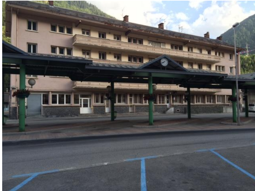
Le bâtiment du SPAF de Modane
