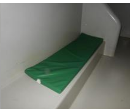
Bat-flanc et muret occultant le WC
