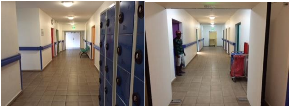
Le couloir du côté des chambres d'isolement (photo de gauche) et de la salle à manger (à droite)
