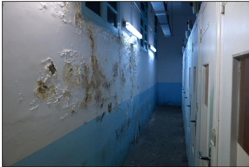
Figure 18 : humidité dans un couloir de parloir
