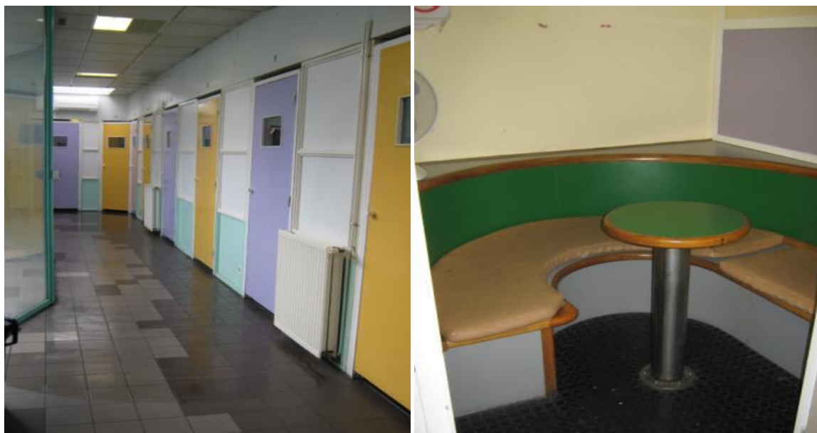
Un couloir desservant des box et l'intérieur d'un box
