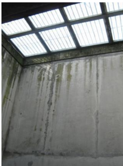
Le toit de la cour
