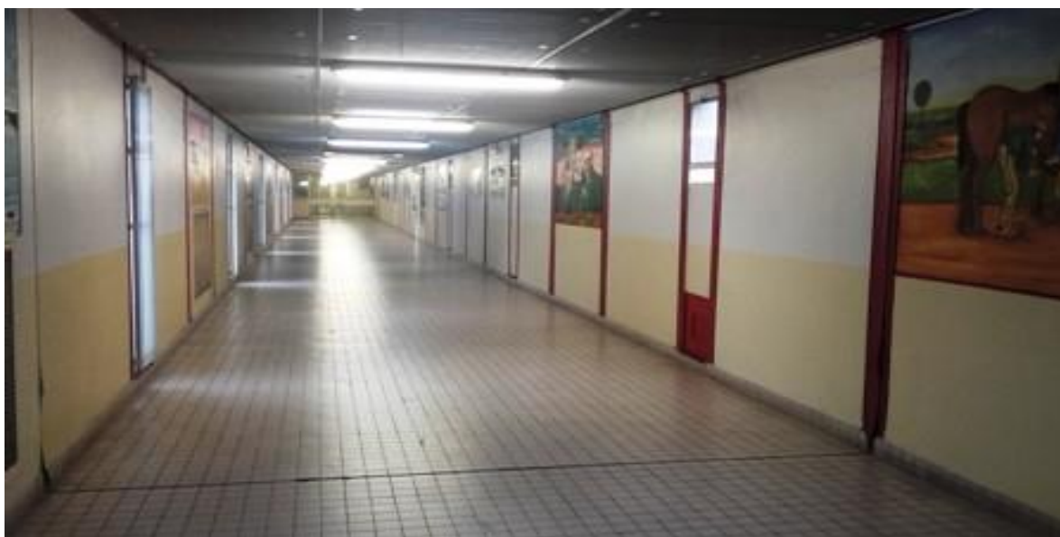
Un couloir de circulation
