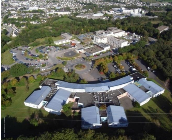
Le pôle Lavalot avec au premier plan le bâtiment Kipfer du pôle psychiatrie
