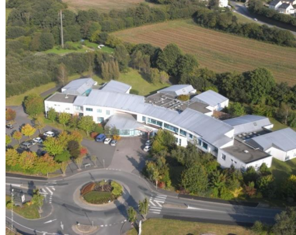
Le bâtiment Kipfer vu du rond-point d'accès
