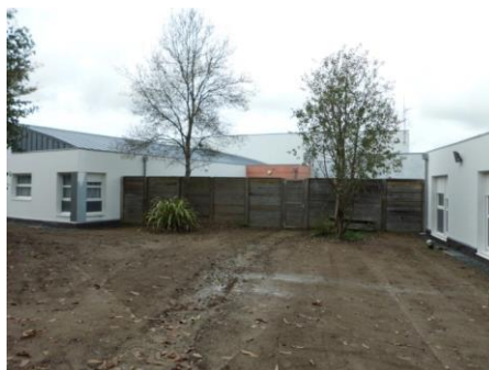
La palissade fermant la cour de promenade.
