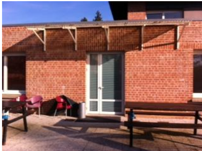
Espace extérieur avec auvent
