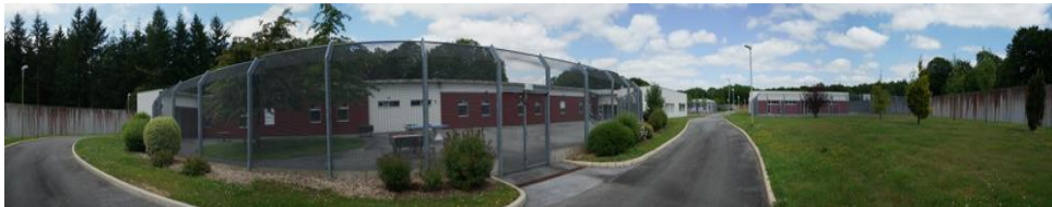
Vue panoramique de l'UMD à l'intérieur du mur d'enceinte
