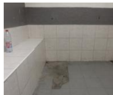
Cellule du vestiaire
