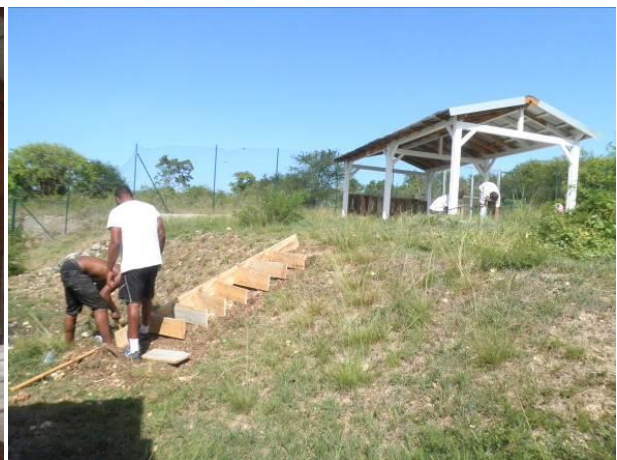
Carbet et escalier en cours de construction
