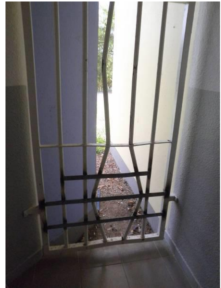
Grille endommagée, après réparation
