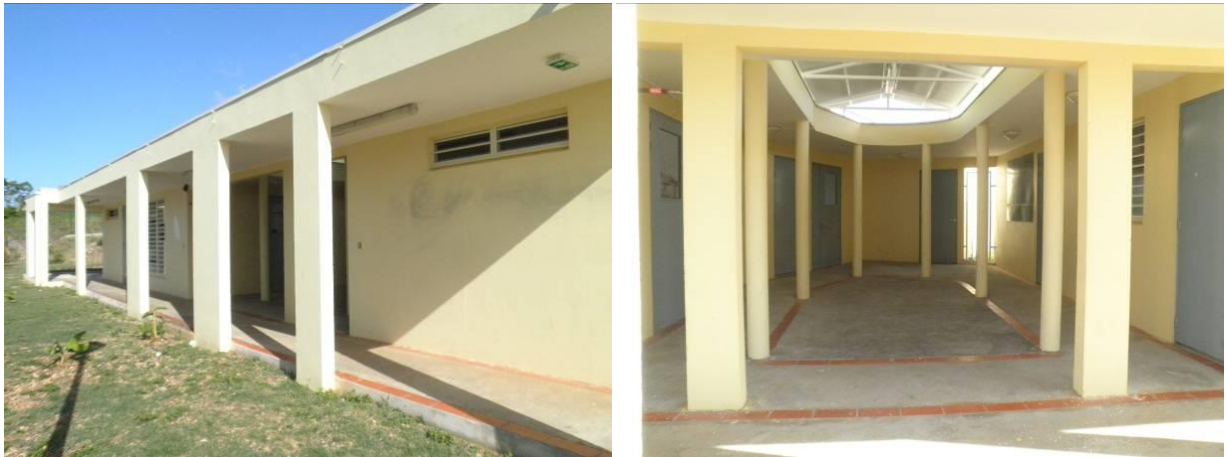
Allée et atrium desservant la zone pédagogique
