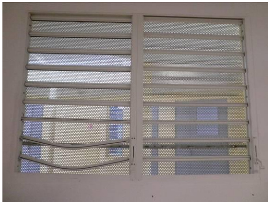
Fenêtre de la salle informatique
