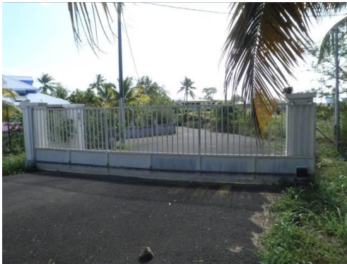
Grille d'entrée du CEF
