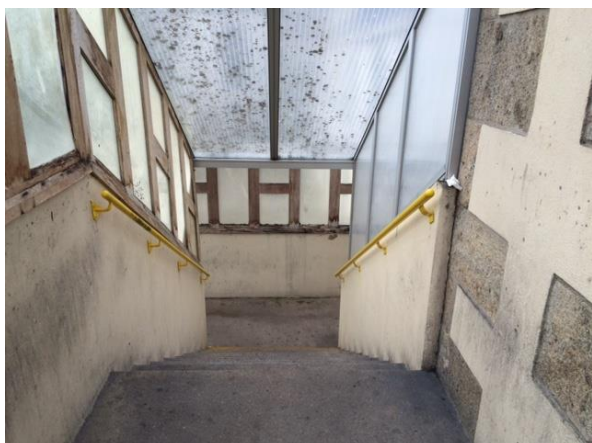
Escalier partie haute
