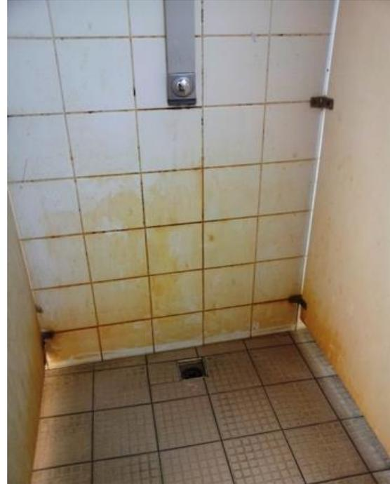
Les peintures s'écaillent, les bouches d'aération sont abîmées, l'ensemble des carrelages est dans un état de saleté repoussant et, au deuxième étage, une seule douche est en état de marche avec de surcroît des problèmes de pression. Les fenêtres des sanitaires, pour la plupart, ne ferment plus et sont coincées par un balai pour éviter les courants d'air froid.
