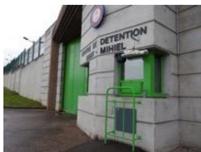
Porte d'entrée principale
