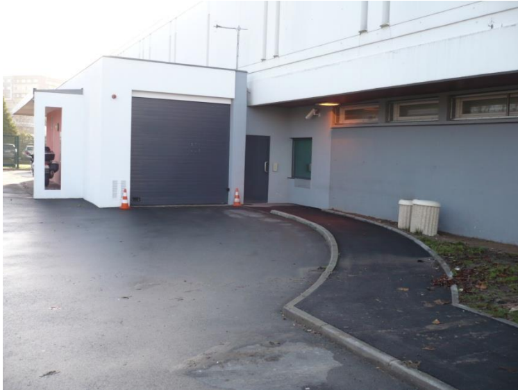
Façade de l'UHSI
