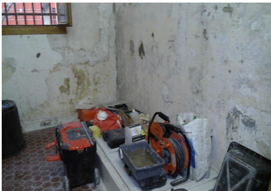
Le chantier des douches des mineures
