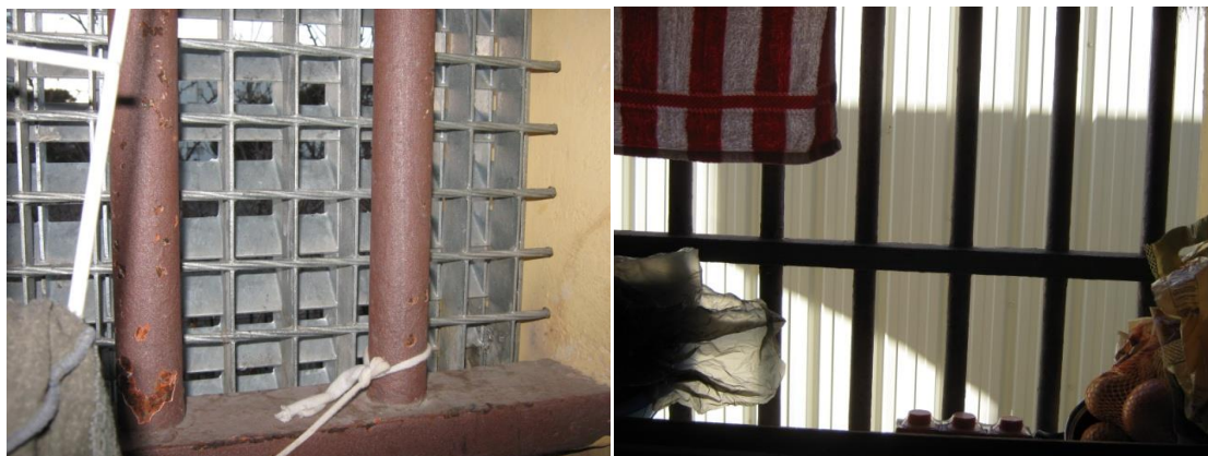
Vues depuis deux fenêtres de cellule au bâtiment H et au bâtiment G
