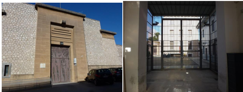
L'entrée du sas véhicules et l'intérieur du sas véhicules
