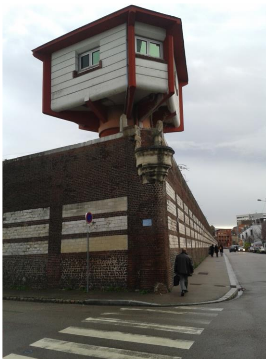
Mur d'enceinte et mirador
