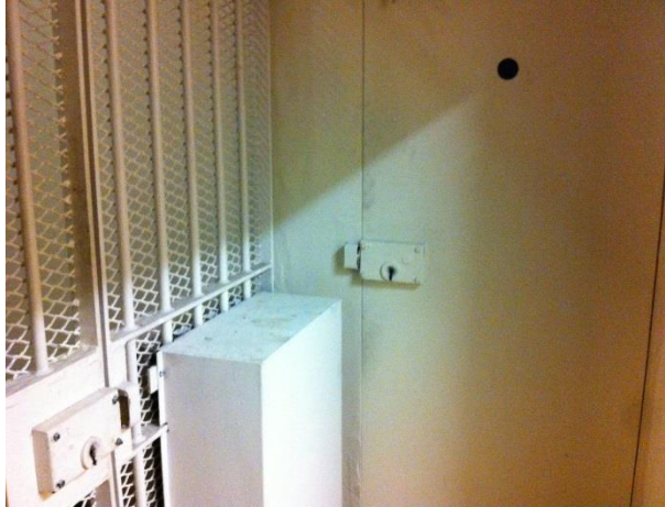
Sas d'entrée de la première cellule disciplinaire avec porte d'entrée de la seconde
