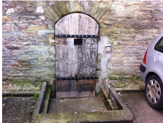
Porte d'accès direct au TGI
