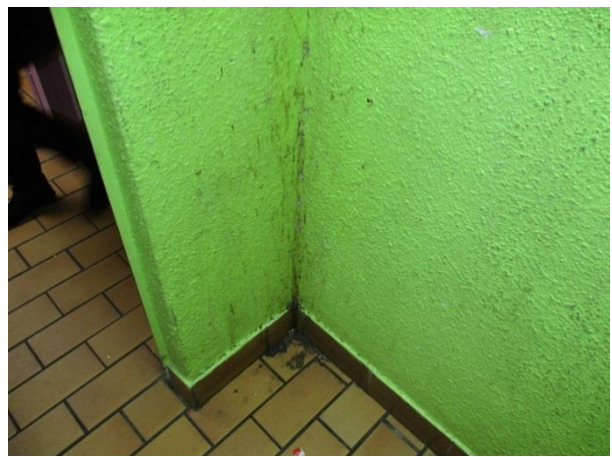
Un box vu de l'intérieur
