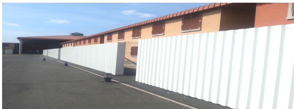
Palissades installées devant les unités
