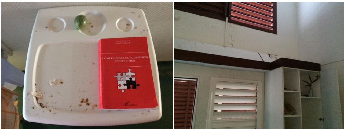
Détails mobiliers d'une chambre
