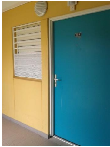
Porte d'entrée d'une chambre
