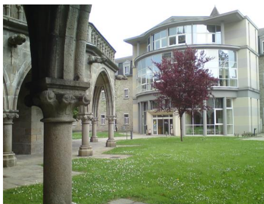
Structure moderne ajoutée au cloître
