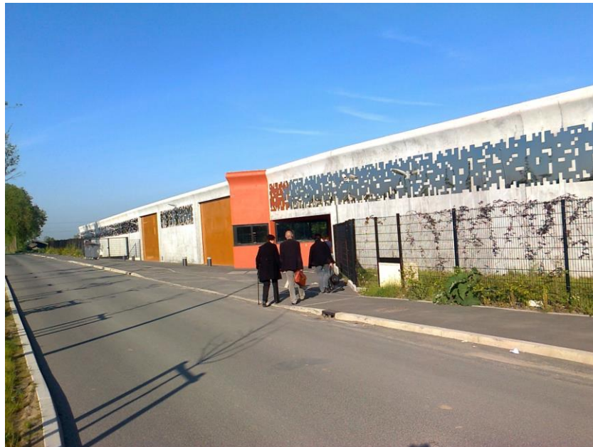
Entrée de l'UHSA
