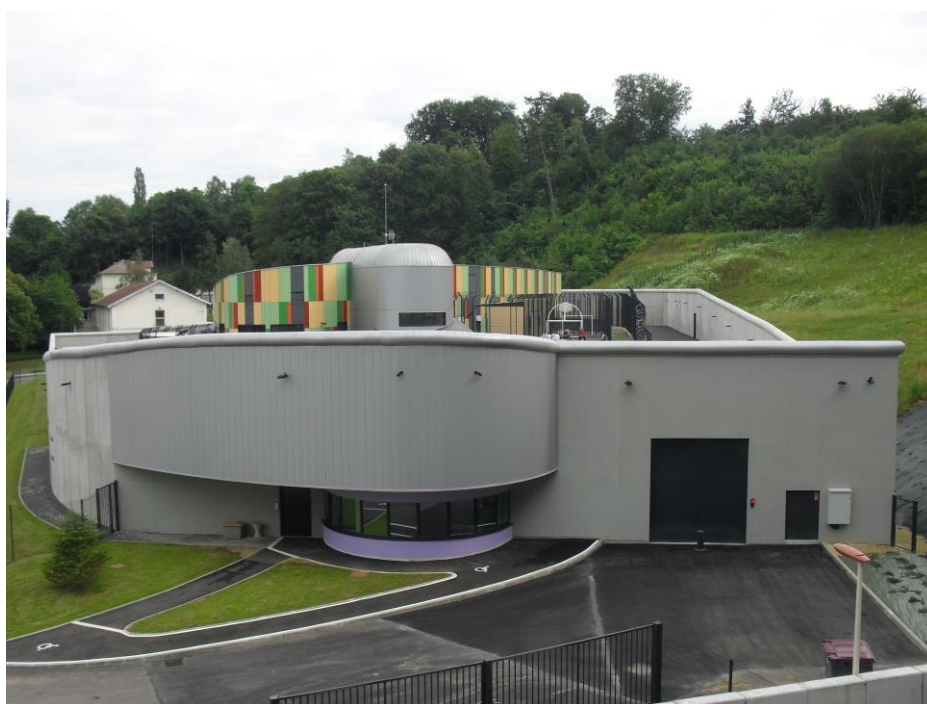
L'UHSA : vue générale
