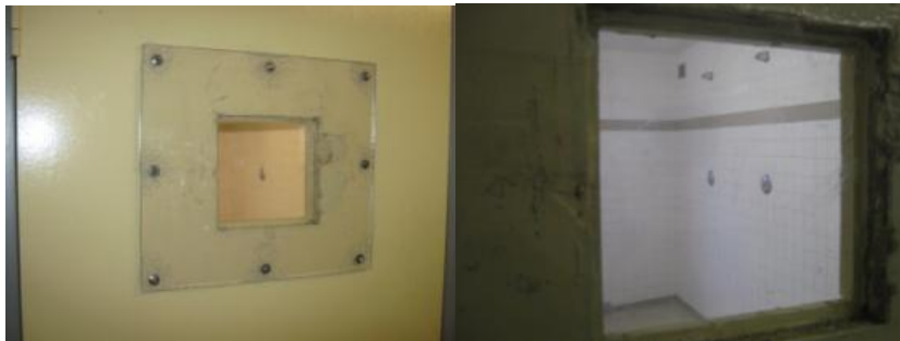
Vues de la salle de douche depuis le couloir du QD
