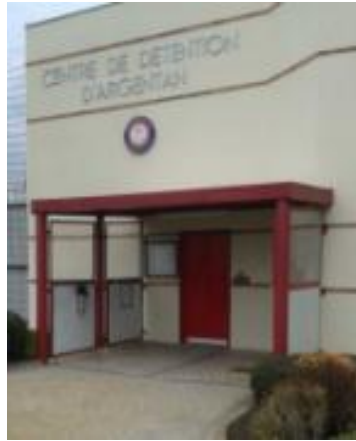
Auvent porte entrée
