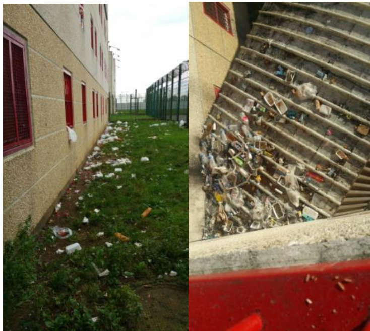
Immondices au pied d'un bâtiment et sur le toit d'une galerie
