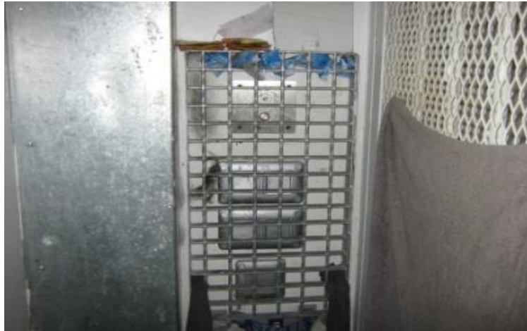
Vue des différentes commandes à disposition dans une cellule disciplinaire
