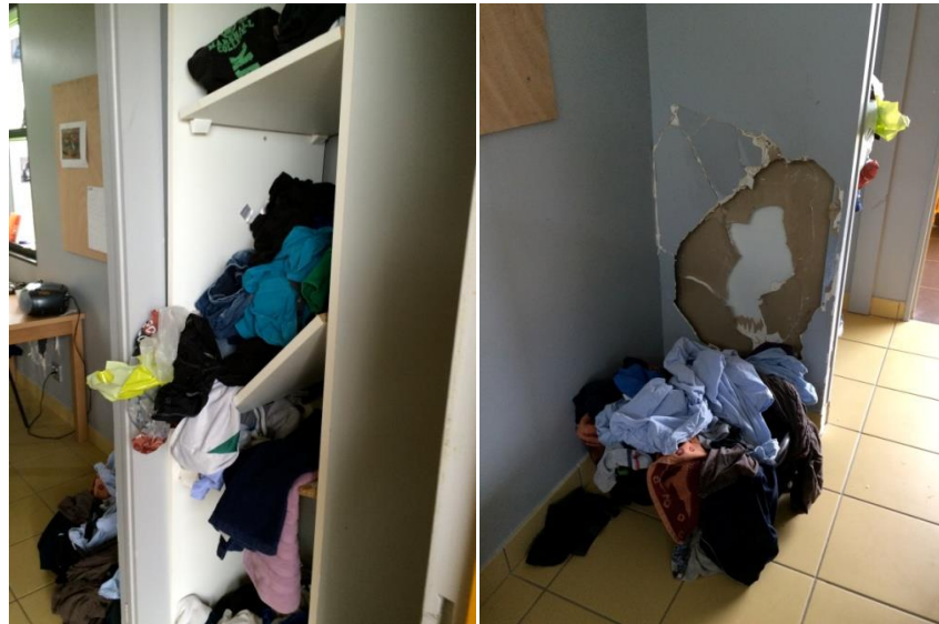
Deux vues d'une chambre
