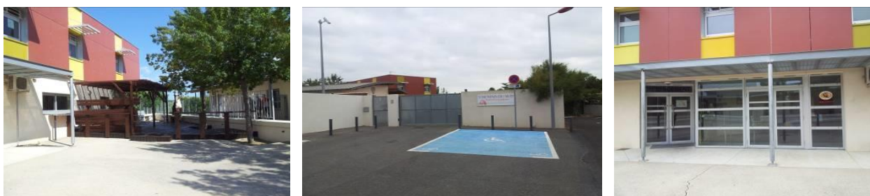
Extérieurs du CEF et entrée
