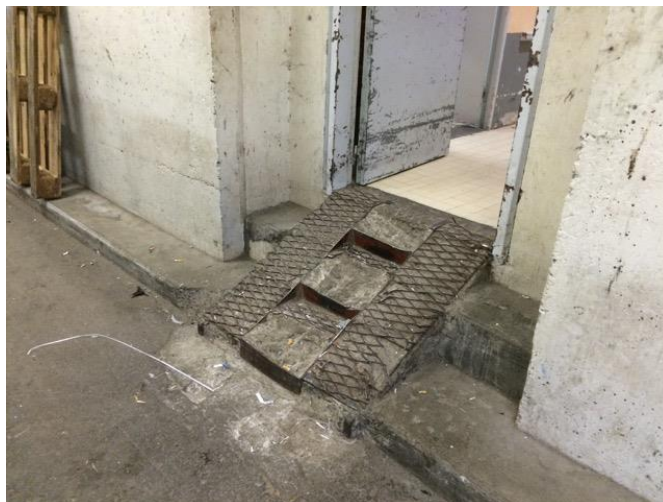
La rampe d'accès des marchandises
