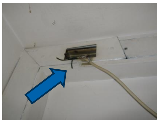
Quelques exemples de prises avec des fils apparents sans protection
