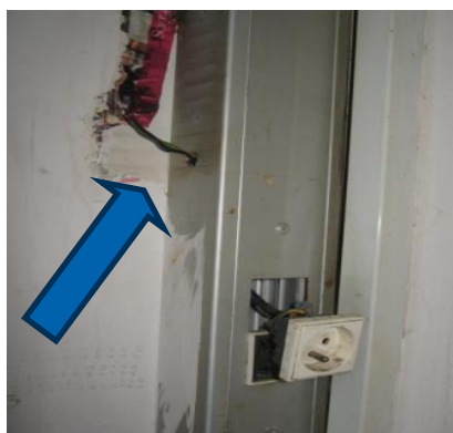
Quelques exemples de prises avec des fils apparents sans protection
