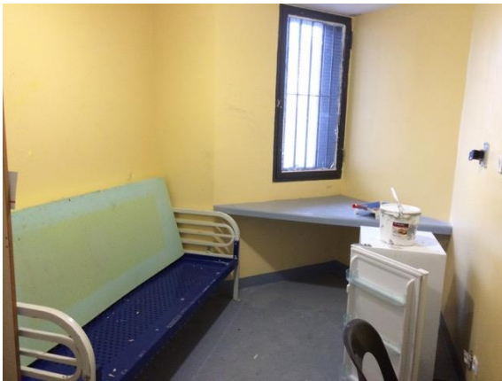
Une cellule en réfection
