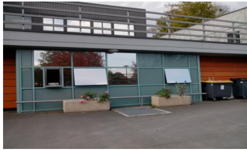
La façade du QSL
