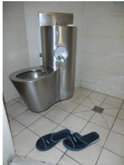
Le bloc sanitaire de la chambre de mise à l'écart
