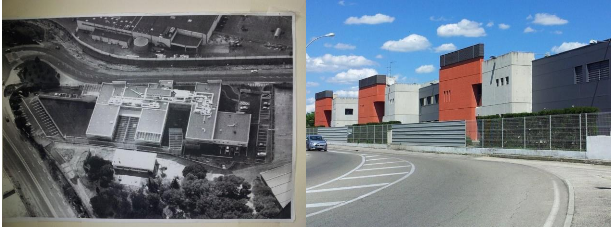
Vue aérienne du CRA
