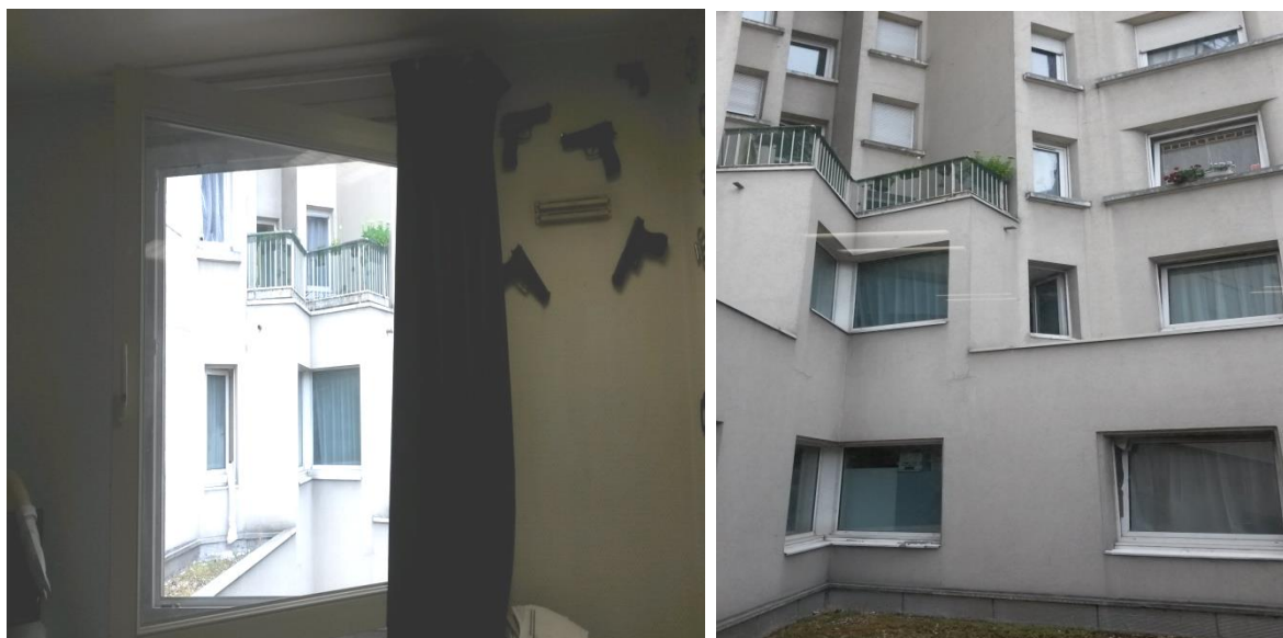
Vue directe sur les locaux du commissariat au rez-de-chaussée
