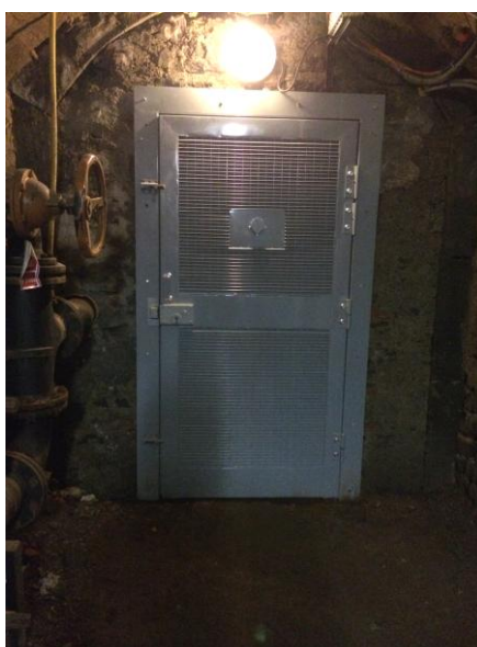
Photo 7 : porte de séparation dans le souterrain conduisant à la cour d'appel
