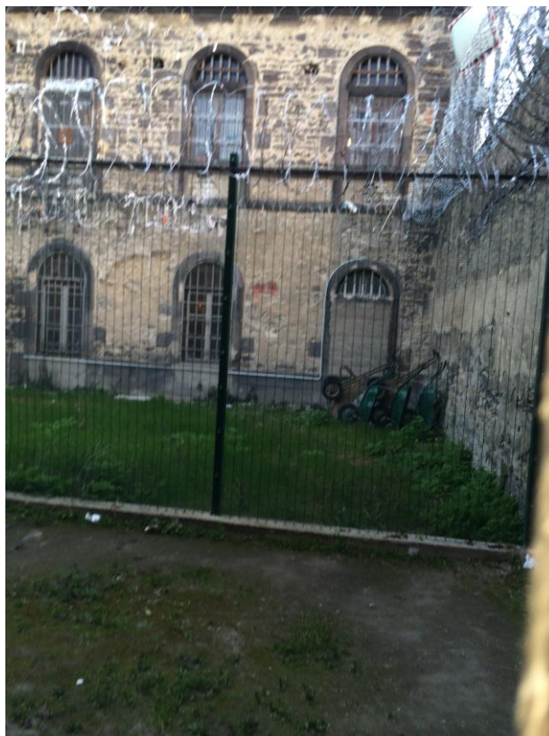
Photo 27 : cour de promenade du quartier disciplinaire (ancienne cour des condamnés à mort)
