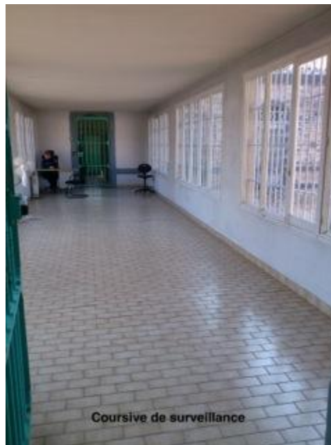
Photo 15 : coursive de surveillance des promenades
