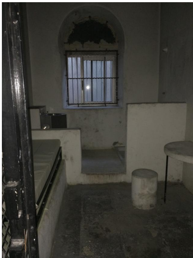
Photo 23 : cellule N° 1 du quartier disciplinaire (cellule non rénovée)
