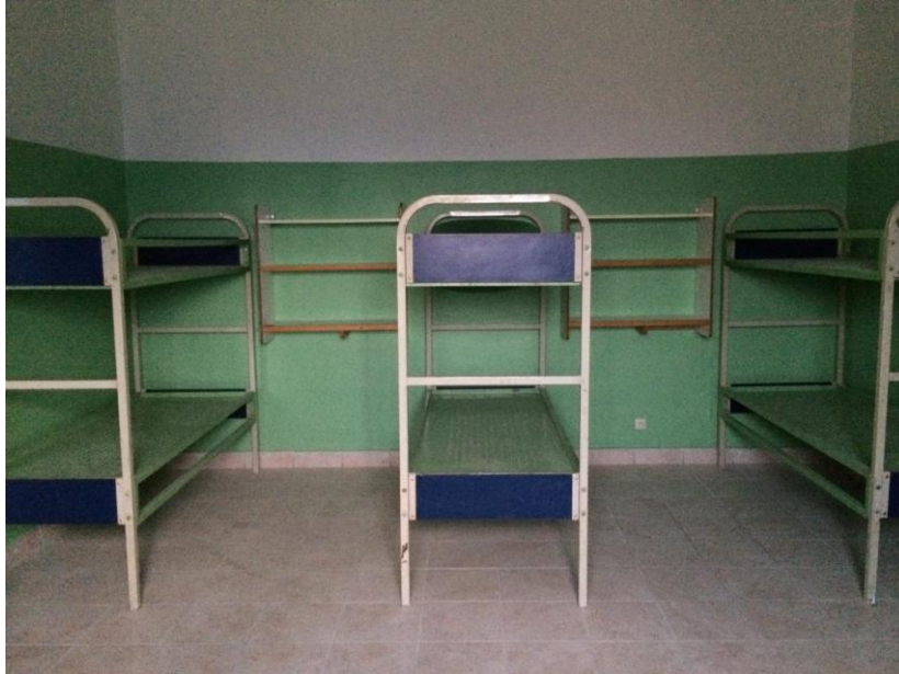
Photo 22 : la cellule des hommes en cours de rénovation (quartier de semi-liberté)
