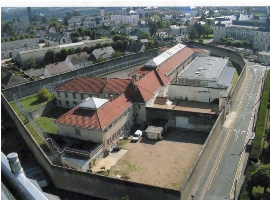
Vue générale aérienne de la maison d'arrêt de Blois
