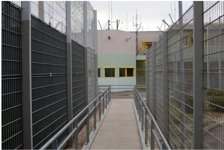
Le couloir de circulation grillagé
