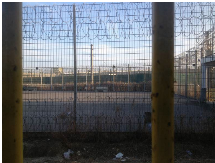
Les protections sécuritaires de la cour de promenade du bâtiment A
