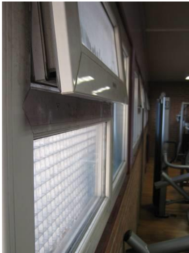
Course de l'ouverture d'une fenêtre
