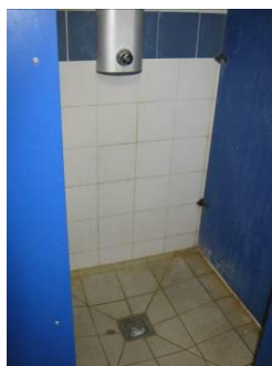
Deuxième cabine de douche
