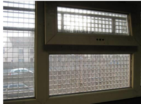
Grillage et barreaudage
