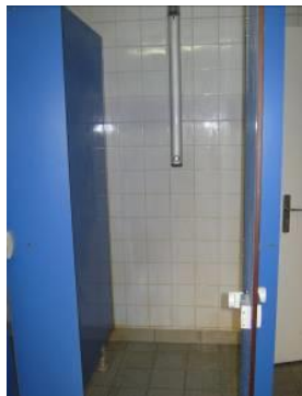
Une des cinq cabines de douche
