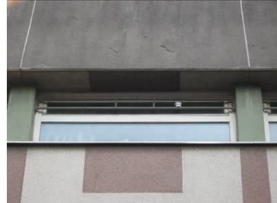
Fenêtre du second niveau
