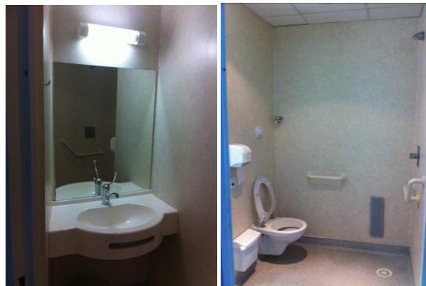
Lavabo sanitaire et toilettes-douche dans une chambre individuelle
