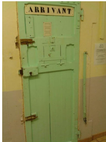
Porte de la cellule arrivant avec sa barre de fermeture nocturne
