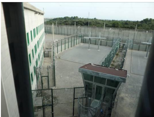
La séparation entre les cours des mineurs et des majeurs au A et les cours du bâtiment B
