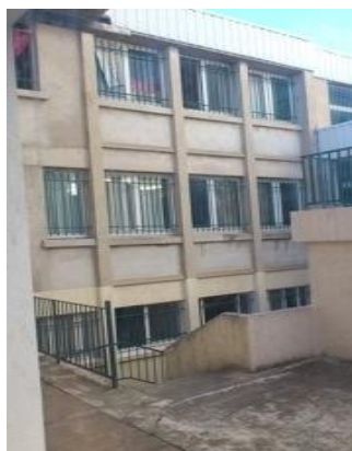
Cellules dans l'immeuble de trois niveaux
