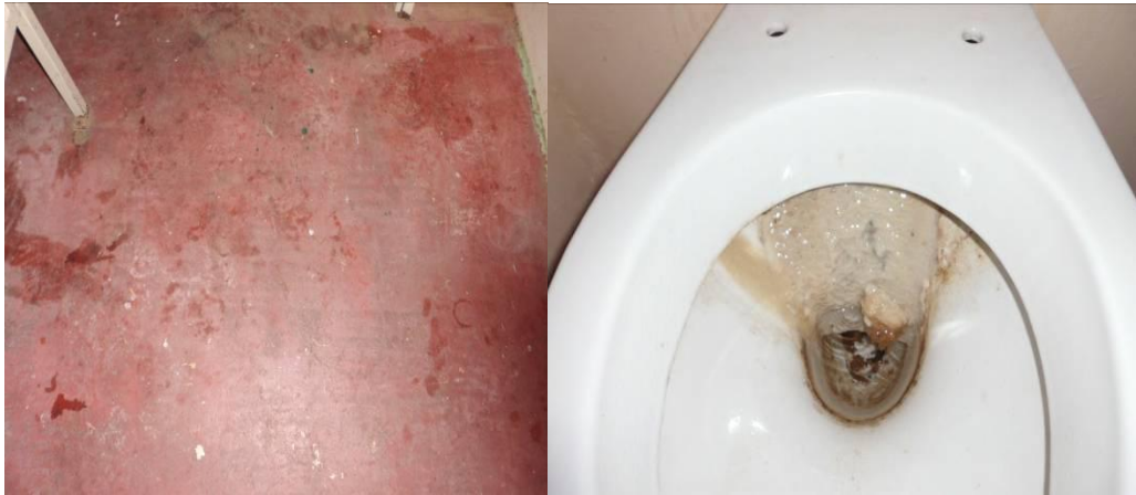
Vues de la cellule n° 469 de confinement (Bâtiment C)
