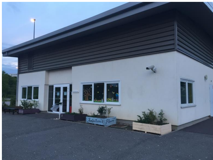
Vue de l'entrée du local d'accueil des familles
