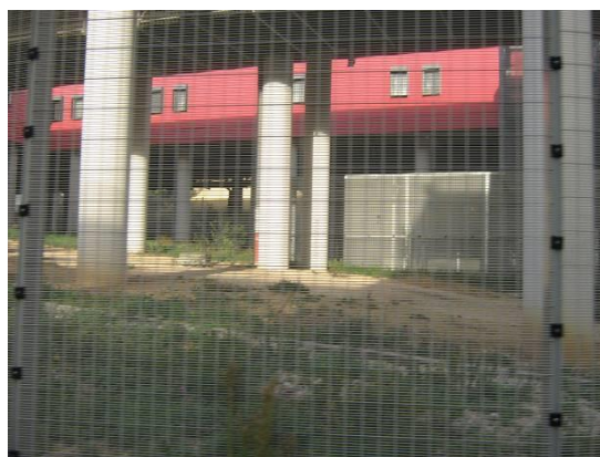
L'espace situé sous le bâtiment de l'UHSI
