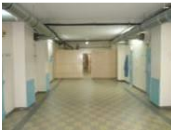
Couloir du quartier disciplinaire
