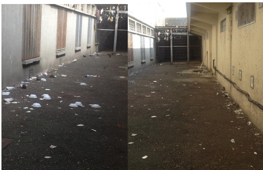
Photos 11 et 12: abords des ateliers de production
