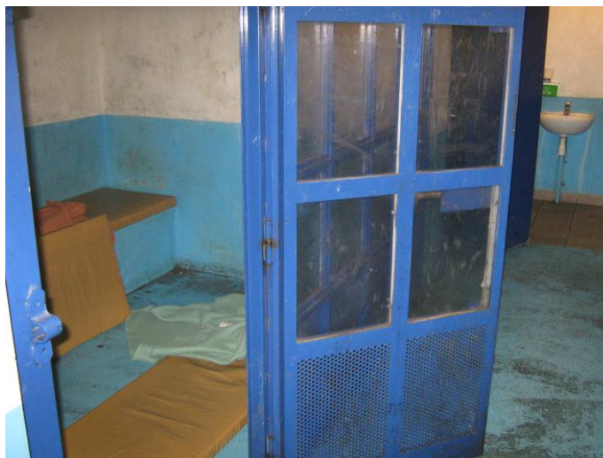
Cellule de garde à vue n°1
