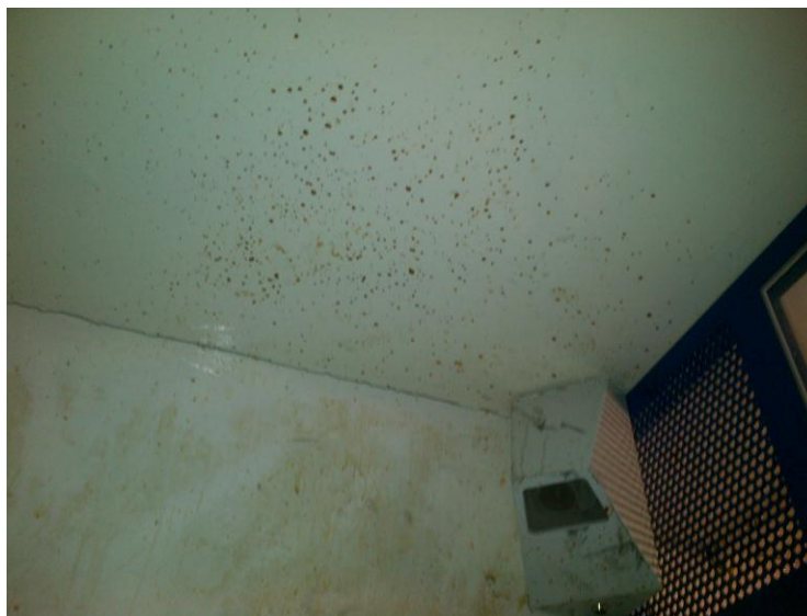
Caméra de surveillance dans la cellule de garde à vue n°1
