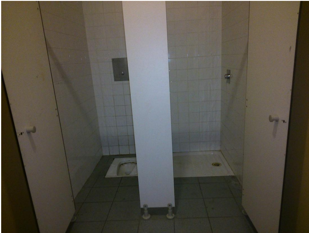
Local sanitaire des locaux de garde à vue
