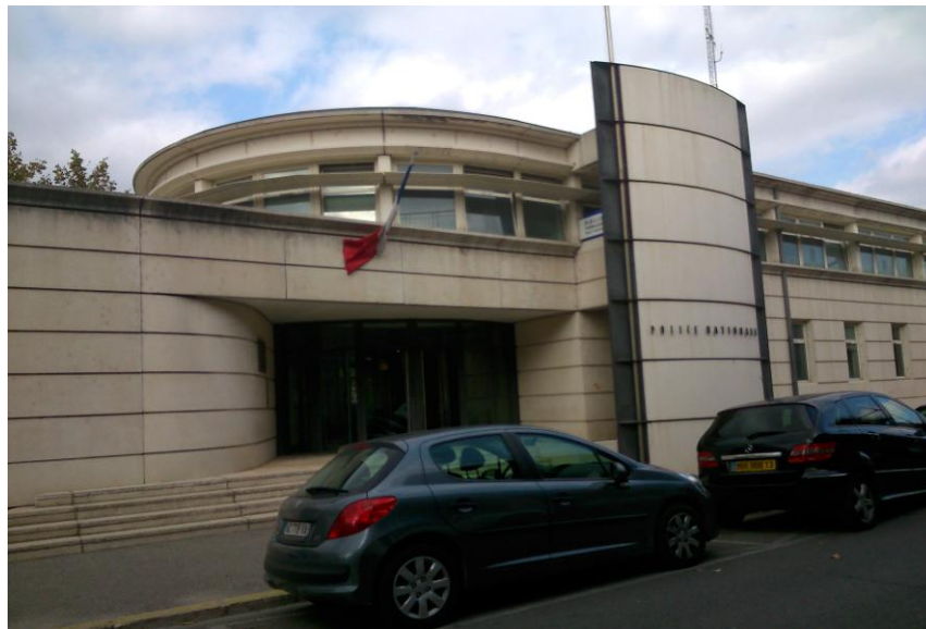
Façade et entrée du commissariat de Tarascon
