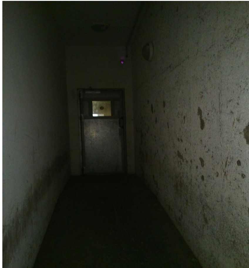
Couloir d'accès des personnes conduites au poste de police
