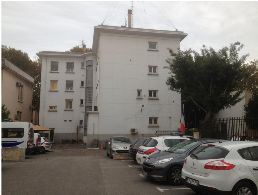
La cour d'honneur du commissariat avec vue sur l'arrière du bâtiment principal
